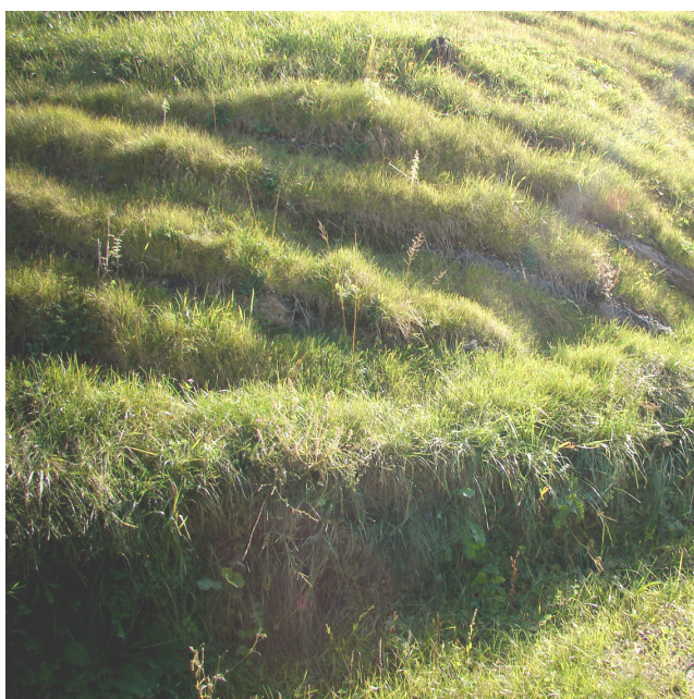
Sliki prikazujeta uporbo tehnologije vegetacijskih pasov za utrjevanje travnate brežine in brega vodotoka. Vir: Biotec Šubic, biotehnična stabilizacija brežin, dostopno: https://www.biotec-int.com/ (julij 2021)
