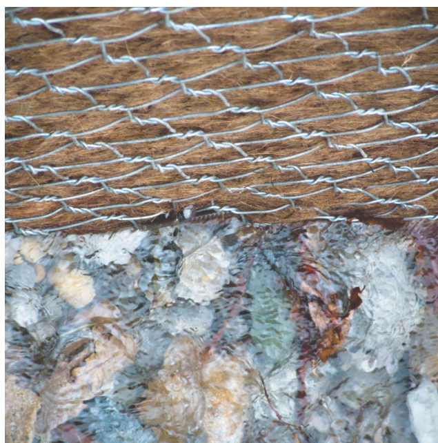
Sliki prikazujeta uporbo tehnologije vegetacijskih pasov za utrjevanje travnate brežine in brega vodotoka. Vir: Biotec Šubic, biotehnična stabilizacija brežin, dostopno: https://www.biotec-int.com/ (julij 2021)
