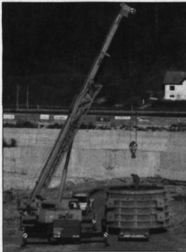
Transport in montaža konusov sesalnih cevi na gradbišču HE Boštanj
