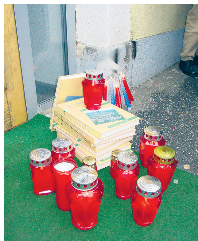
Prižigane sveče naj bi poškodovale fasado na občinski stavbi
