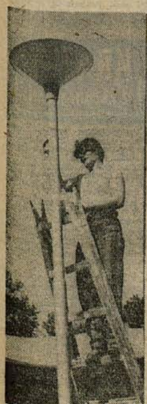
Te dni je v Čateških Toplicah na gradbišču novega hotela in restavracije kot v mravljišču: asfaltirajo ceste, polagajo tla, urejajo okolico, pleskajo stene in tudi že čistijo nove prostore, da bo do otvoritve tega velikega objekta vse pripravljeno. — Na sliki: živosrebrna razsvetljava dobiva zadnji premaz.
