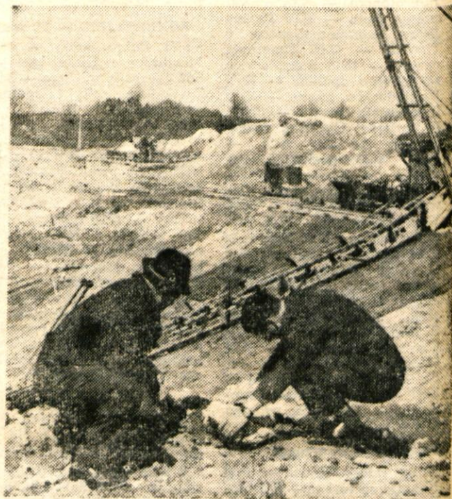
Glinokop v Bobovku, kjer so odkrili ostanke rib
