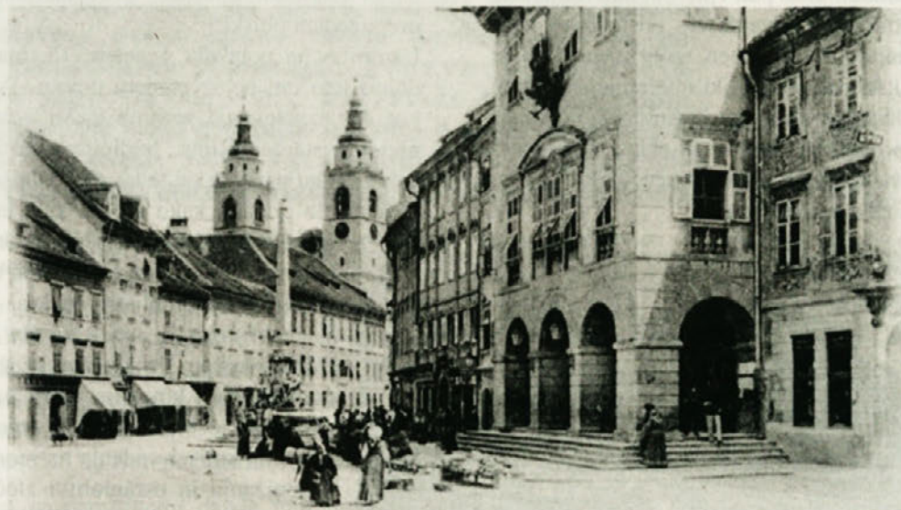
Sedanji magistrat v Ljubljani, tedaj poznan pod imenom »Rotovž«, pred katerim so izrekli sodbe. Slika je iz 19. stoletja. V 17. stoletju sta pred stavbo stala še sramotilni steber in železna kletka, kjer so hudodelce izpostavljali posmehu ljudstva.
