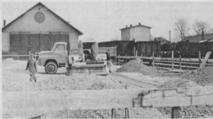
Dela na novi montažni hali lepo napredujejo!
