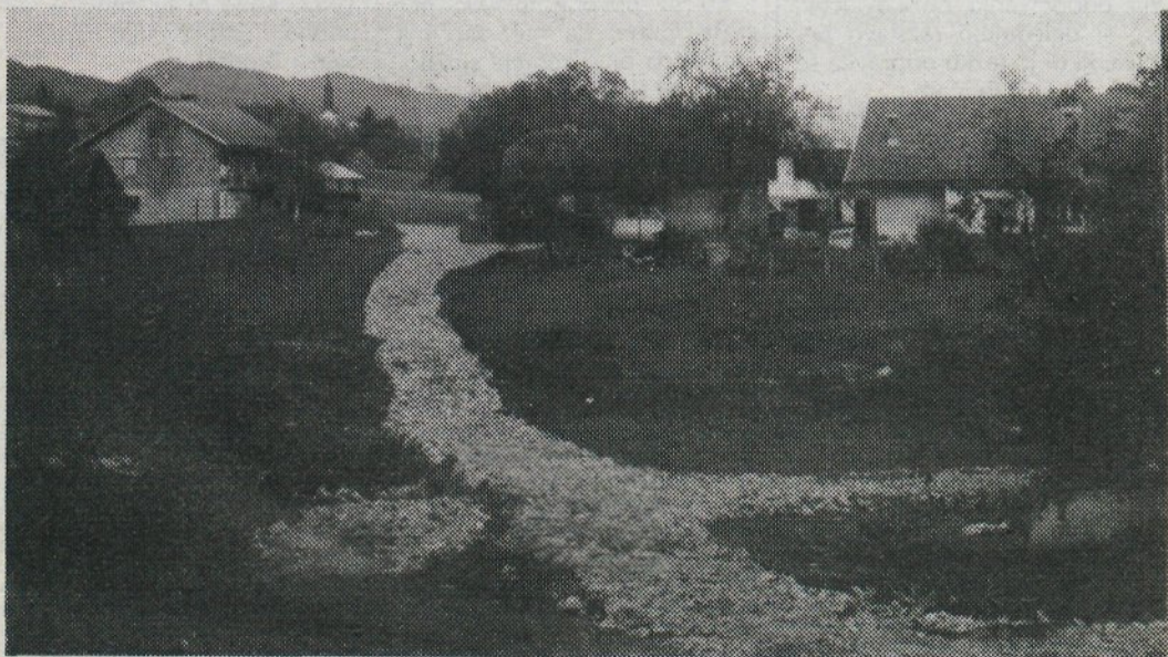
Še nedokončana nova cesta v Dvorjah
