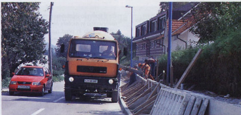
Gradnja pločnika na nevarnem odseku v Rakovniku.
