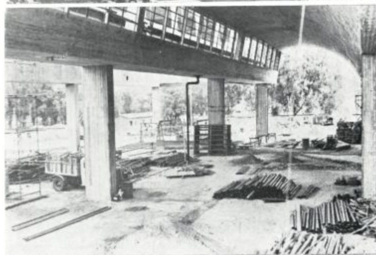
NOTRANJI POGLED MED GRADNJO
