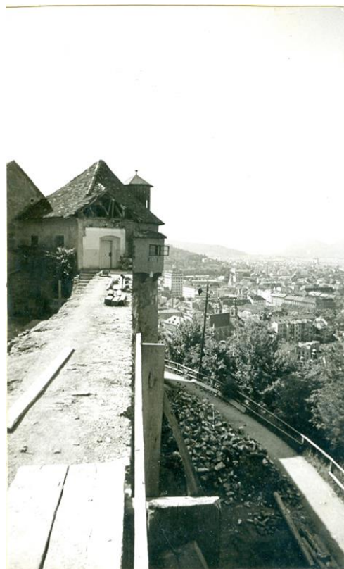
Slika 48: Ljubljanski grad, izgradnja razgledne terase, 1941 (?)
