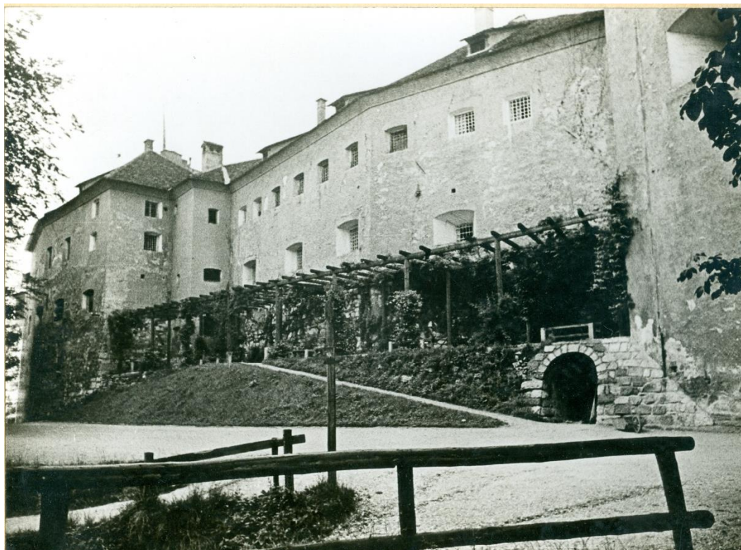
Slika 62: Ljubljanski grad, pergola zaljubljenecv, 1941 (?) Nahajališče: Iz arhitekturne zbirke MAO, arhiv arhitekta Borisa Kobeta
