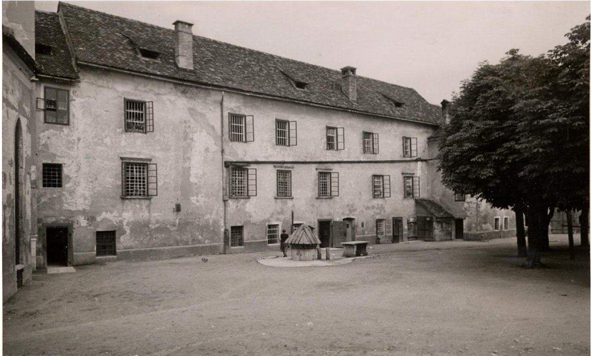
Slika 51: Ljubljanski grad, pogled proti vhodu v Razgledni stolp ter trakt s kaznilnicami, 1941 (?) Nahajališče: Ministrstvo za kulturo, INDOK center, fototeka
