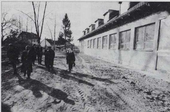
Slovenski kulturno-informativni center v času gradnje
