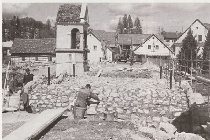
Krepka rekonstrukcija, pravzaprav temeljita obnova mirnskega mostu zahteva izkušene strokovnjake. Gradisovi delavci to očitno so, vendar pa bo, žal, most še vedno prometni zamašek pri še vedno naraščajočem prometu, saj ostaja istih dimenzij. Za tolažbo bo zgrajena lesena brv za pešce. Tako odločitev je sprejel Zavod za spomeniško varstvo. (foto: D. Z.)
