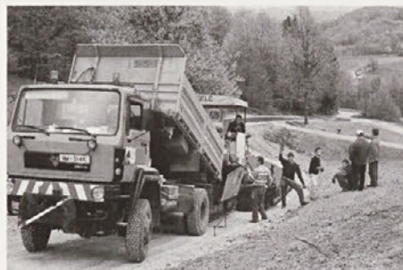
Delavci Cestnega podjetja Novo mesto so se tik pred prvomajskimi prazniki krepko potrudili in poasfaltirali še zahteven klanček pred Kovačičevo hišo pod kočjo Plaz na Debencu. (foto: D. Z.)
