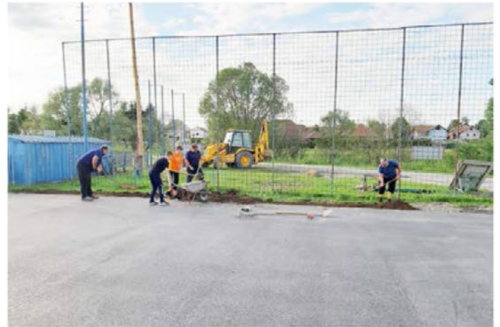
Preplastitev igrišča v Športnem parku in dela ob objektu
