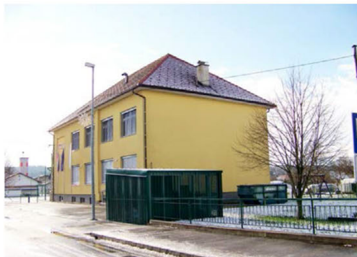
Pri OŠ Sela je dokončana izgradnja pokritega prostora, v katerem so zabojniki za smeti.
