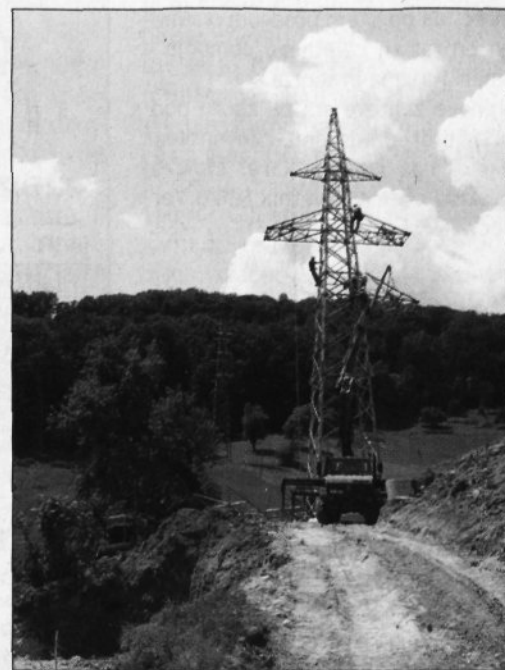
Postavljanje stebra za 110-kilovoltni daljnovod nad Boštanjem
