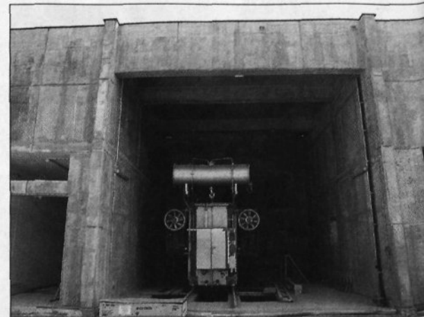
Glavni energetski transformator je že na svojem mestu.
