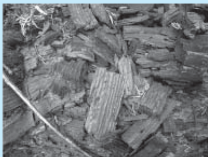
□ Slika 5. Z glivami rjave trohnobe razkrojen les Figure 5: Brown rotted wood
