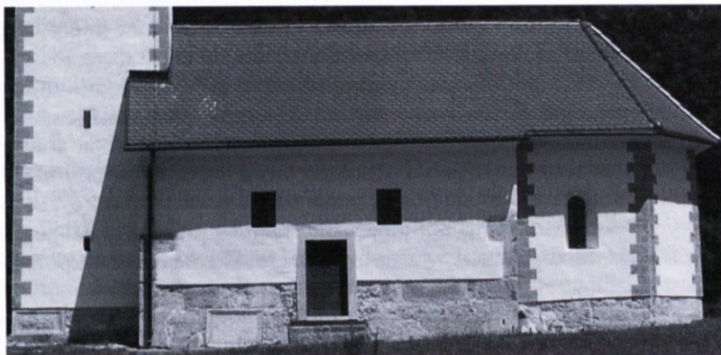
Južna fasada cerkve po obnovi. Foto: F. AŠ, arhiv ZVKDS, OE Novo mesto
