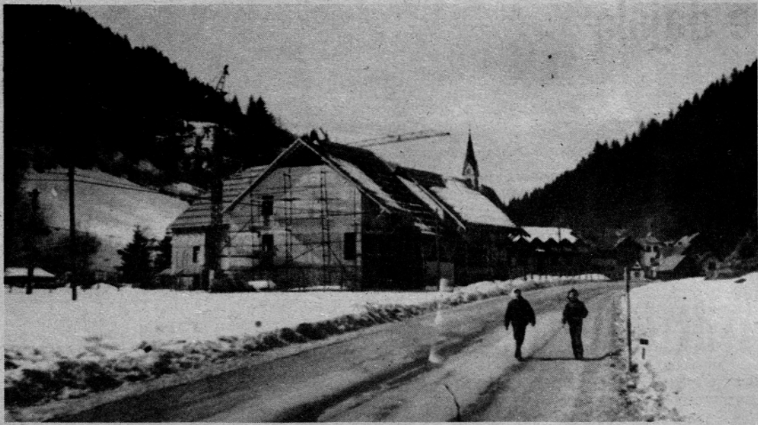
Solčavska večnamenska stavba raste:
