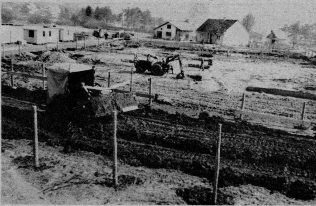
Gradbena dela za strojno postajo GG so se pričela
