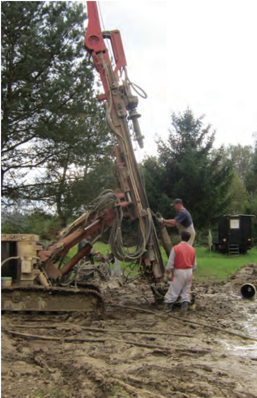
Vrtanje pilotov za točko
