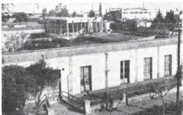
Naš dom v San Justu. V ozadju že postavljena enonadstropna železobetonska konstrukcija v izvajanju načrtov za razširitev Našega doma.
