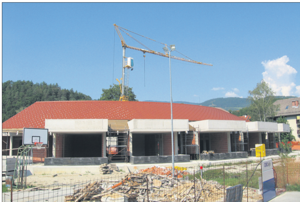
Žalostni prizor z Dobrne, z gradbišča novega vrtca, ki sameva že en mesec.
