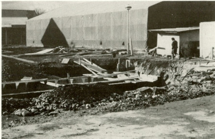
Gradnja jame za sisterno kurilnega olja
