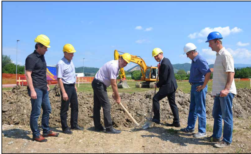
Takole so v začetku junija simbolno zasadiji lopato direktor Novema Matjaž Omladič, predstavniki izvajalca del Remonta, projektantskega podjetja in nadzora.
