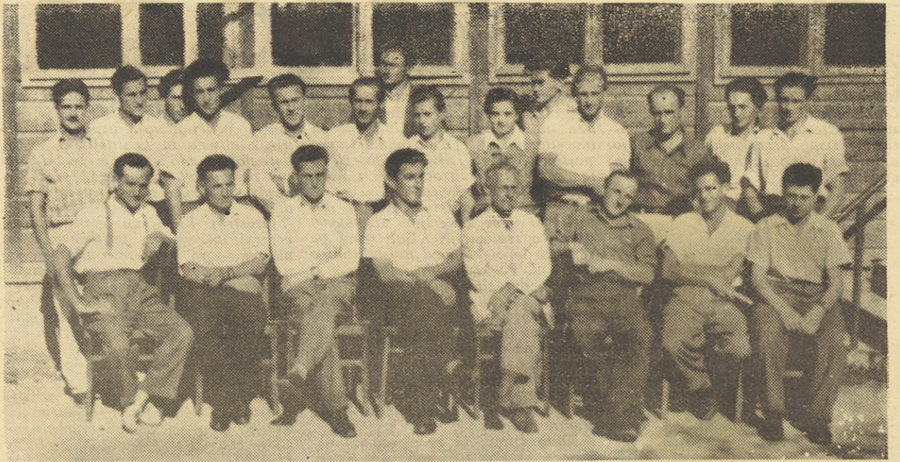
Delavski svet ravenskega gradbišča v letu 1952
