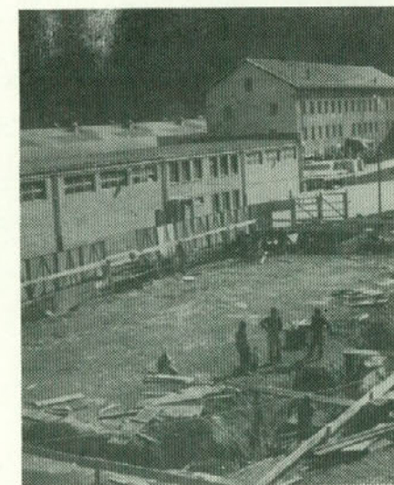
Pogled na gradbišče novega obrata družbene prehrane
