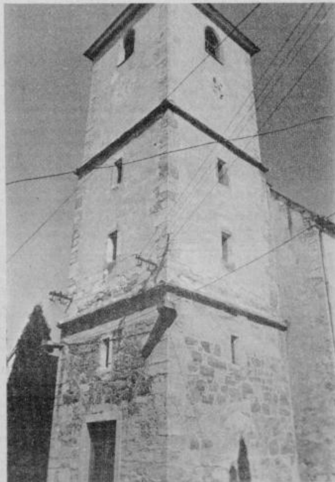
Cerkev sv. Andreja iz leta 1513 so »okrasili« z električno napeljavo. Morda takrat še niso poznali podzemnih električnih vodov.
