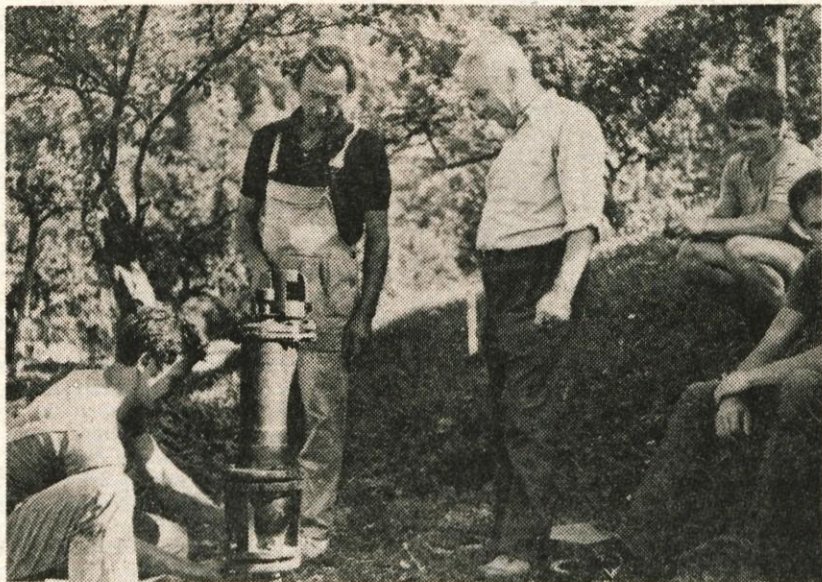
ŠE PRIKLJUČKE — Ivan Dobovšek iz Sidraža si je dal opraviti z vodovodnimi priključki.
