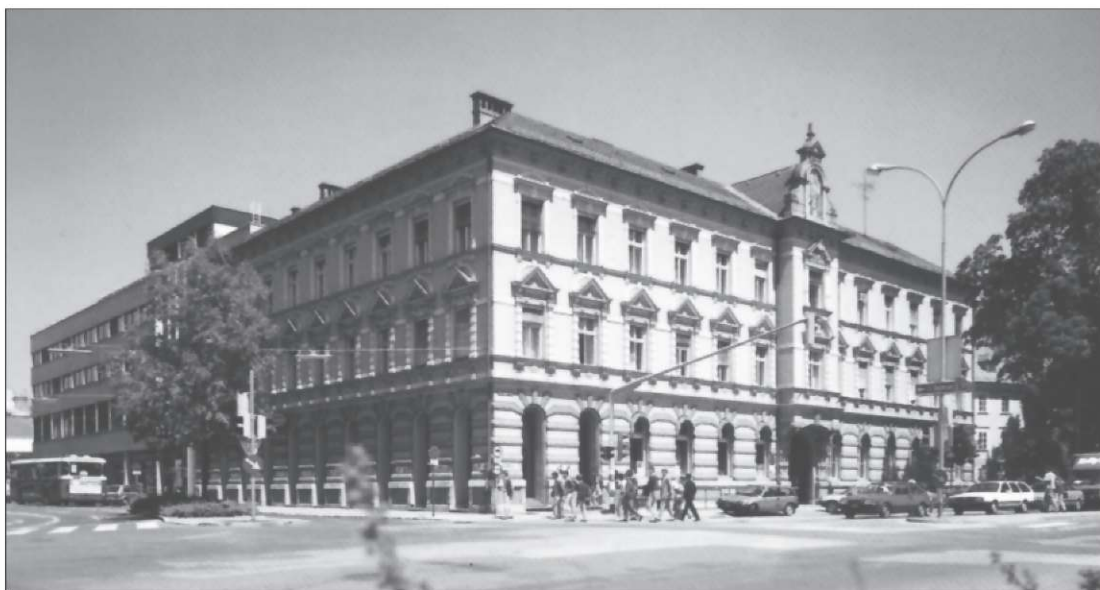
Dom Mohorjeve družbe v Celovcu
