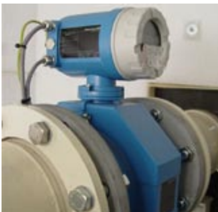
Merilnik gostote črpane stare sadre v strojnici bagra
