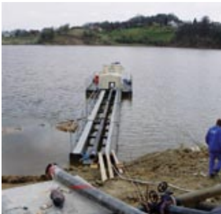
Priključevanje plavajočega cevovoda na prebodu voda - kopno
