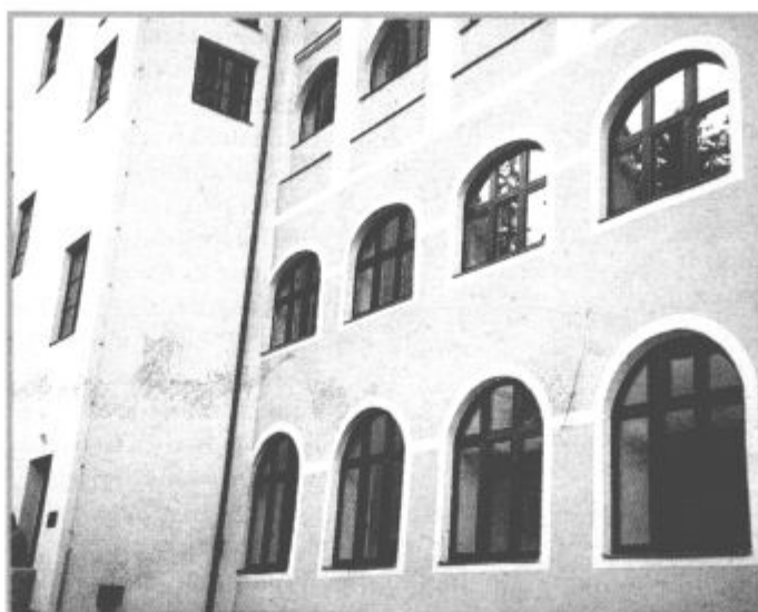
Za rumeno fasado se skrivajo sodobna stanovanja.
