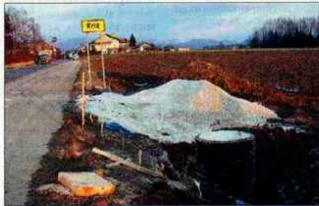
Na Križu se je začela gradnja kanalizacije v občini.
