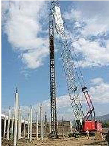
Slika V.5. Izvedba pilotov.
