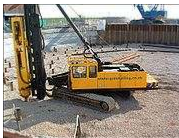
Slika V.10: Izvedba zabutih pilotov
