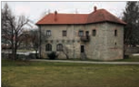
Ostanek na južni stolp in jugozahodno stranico protiturškega obzidja prizidanega nadstropnega jugozahodnega stranskega grajskega poslopja (foto: Igor Sapač, 2018).
