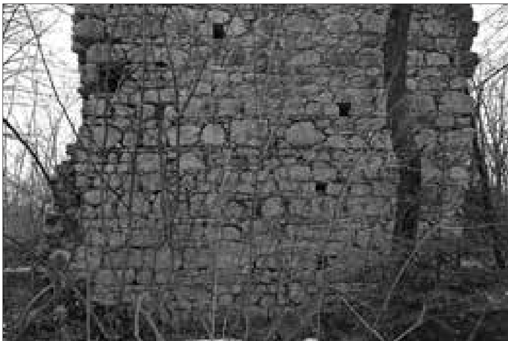
Struktura kamnite zidave v spodnjem delu zunanje strani visokega ostanka severovzhodne fasadne stene glavnega grajskega poslopja (Igor Sapač, 2018).
