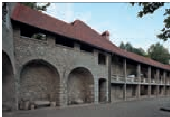
V 17. stoletju na dvoriščno stran vzhodnega stolpa prizidane arkade (foto: Igor Sapač, 2018).
