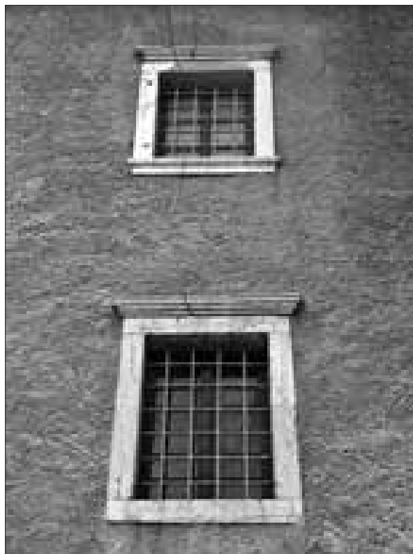
V 17. stoletju so na vhodnem stolpu prvotne strelne line nadomestili z večjimi okni s kamnitimi okviri renesančnih oblik (foto: Igor Sapač, 2018).
