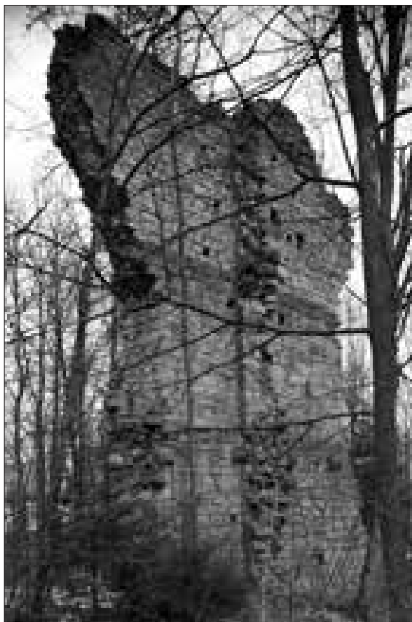
Pogleda z notranje strani na strukturo zidave visokega ostanka severovzhodne fasadne stene glavnega grajskega poslopja (Igor Sapač, 2018).
