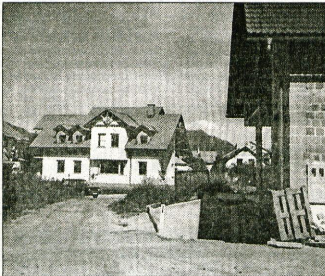
V novem zazidalnem kompleksu je približno polovica hiš že zgrajenih, prihodnje leto dobe krožno cestno povezavo.
