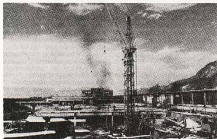
Izgradnja nove smučarske hale B 1 (na sliki)
