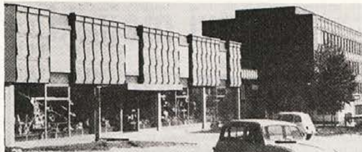
Izgradnja nove trgovine Elan v Begunjah 1973 (na sliki)
