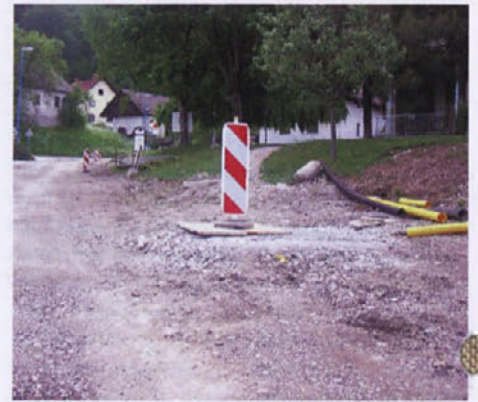
Kanalizacijo so v lanskem letu gradili tudi v Sori.
