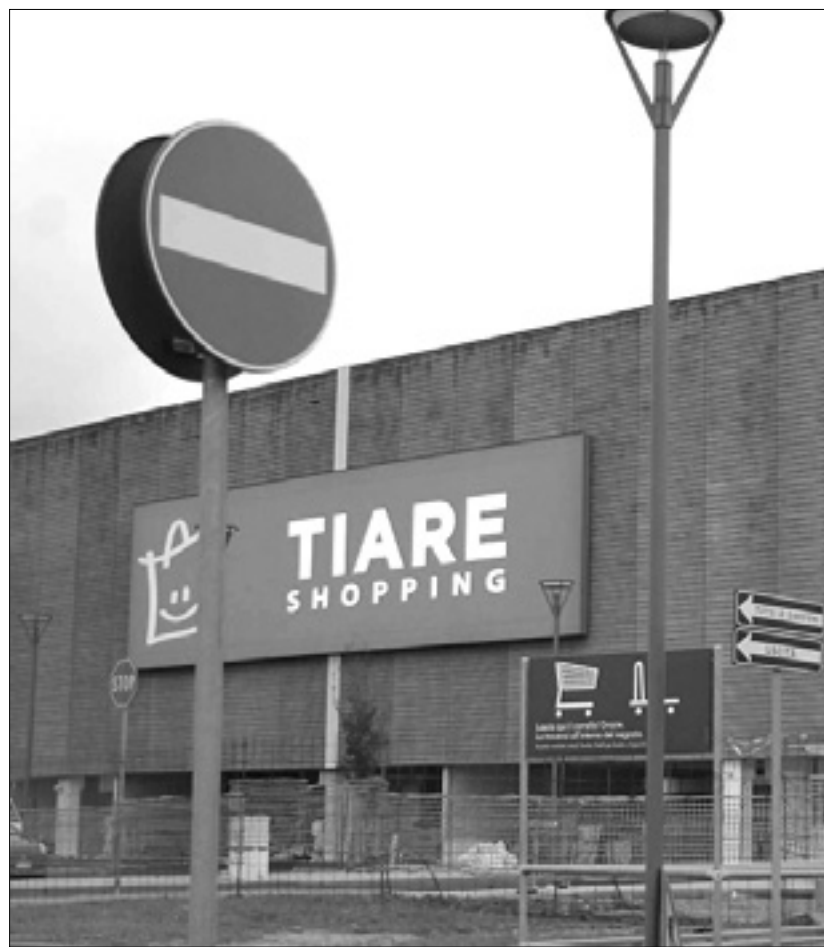
Gradnja nakupovalnega središča v Vilešu še ni zaključena
