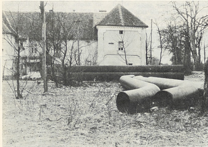
Plinovod bo speljan tudi v neposredni bližini fužinskega gradu. Cevi so pripravljene (Foto: C. Zupancič)
