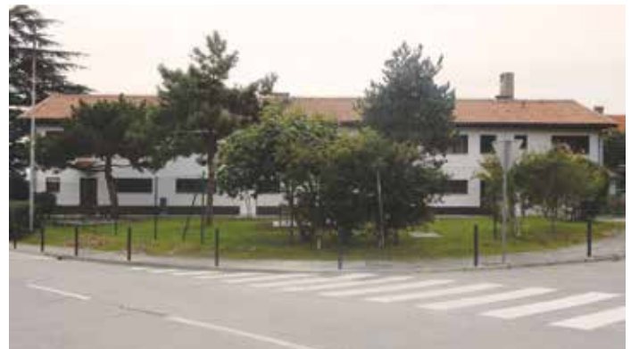
Dom družbenih dejavnosti je dobil tudi novo fasado. / La Casa delle attività sociali con la nuova facciata. (Foto: Aljaž Kužner)
