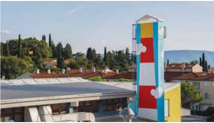
Na novo urejena dimnik in pročelje šole. / Ristrutturati il camino e la facciata della scuola (Foto: Jaka Ivančič)
