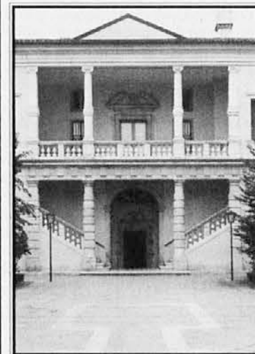
Notranja fasada palače Torriani (Foto Scлаuzero)
