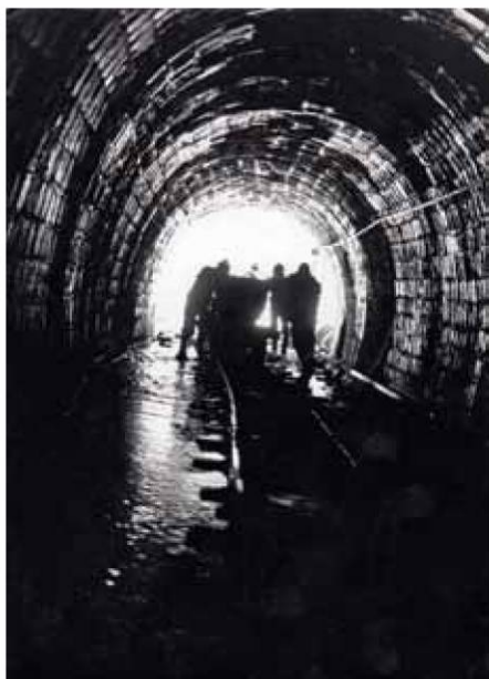
Rudnik se je prvih dvajset let raziskoval klasično – z vodoravnimi obzorji, rovi majhnega profila in s tirno mehanizacijo. Slika iz sedemdesetih let prikazuje ročni izvoz izkopsnine v zgornji jami skozi rov P-9. (foto: Vlastja Simončič)
