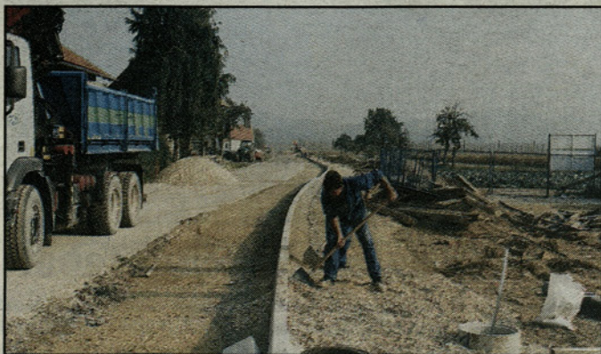
Dela pri razširitvi ceste in pločnika
