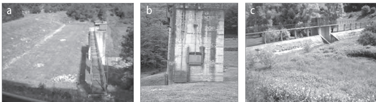
Slika 2: (a) Pregrada Vonarje po izpraznitvi, (b) stolp za odvzem za vode, (c) »lovilna« pregrada Prišlin (foto: Mitja Rismal, 2014)
