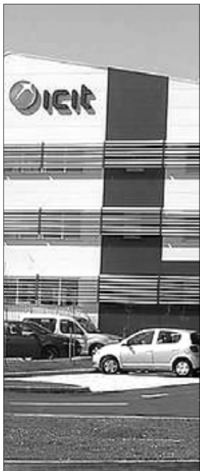
ICIT-ova poslovna stavba v Vrtojbi
