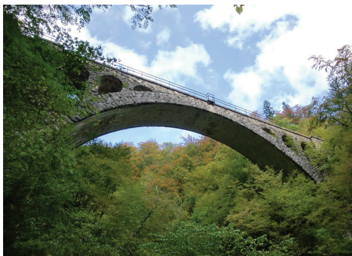
Sliki 1. Kamniti železniški most na Bohinjski progi v Vintgarju ima razpon loka 41 m. Foto: Wikimedia [Wikimedia, 2009].
