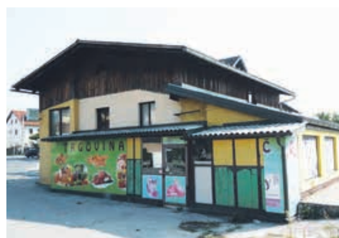
Stavba nekdanje Zelene doline
