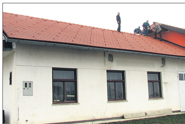
Člani PGD Desenci so ob veliki pomoči krajanov popolnoma prenovili ostrešje na vaškem domu, v kar so vložili kar nekaj denarja (za nakup lesa in kleparskega materiala) ter preko 800 prostovoljnih delovnih ur.
