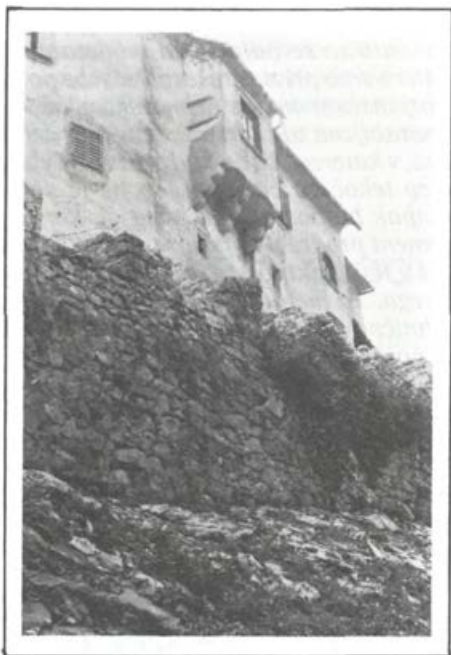
Sanacija grajske- ga obzidja leta 1979
