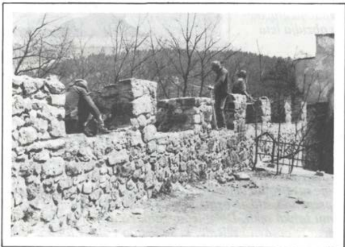
Sanacija grajskega obzidja leta 1979 .
