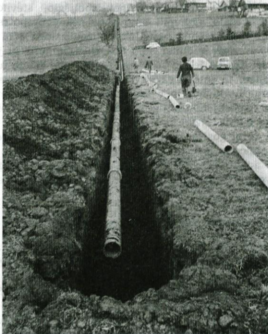
Gradnja cevododa iz rezervoarja na Perovem v smeri Motela Grosuplje
