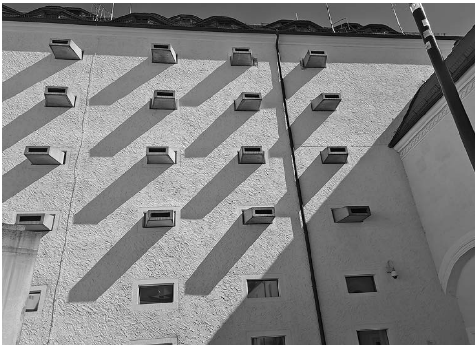
Zunanji izgled fasade dela mestnega gradu v Freibergu, katerega so preuredili v sodobne depoje. Od prvotnega gradu je v tem delu stavbe ostala samo zunanja lupina. Nove depoje so zgradili za zunanji zidovi kot samostojen objekt (Foto: Vinko Skitek)
